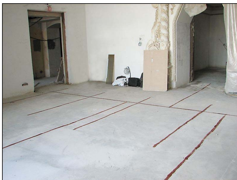
Рис. 9. Результат обследования пола в гостинице Ленинградская с указанием истинного положение труб
