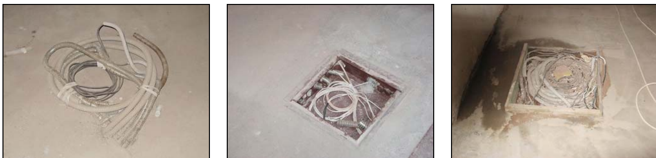
Рис. 3. Кабели в бетонной стяжке
